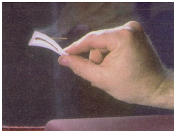
شکل ۳-۲۶- کندن نوار روی شیشه
